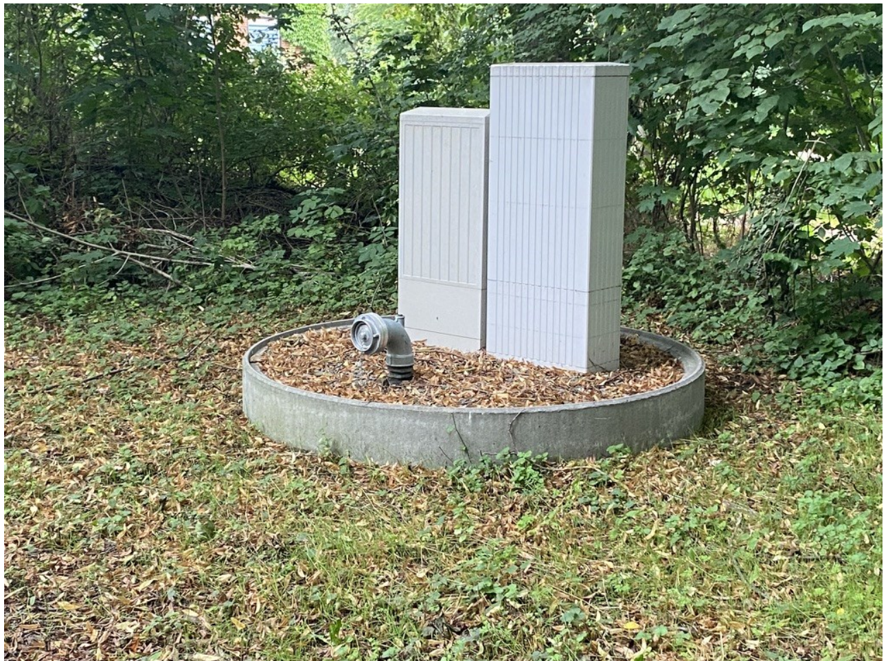
Abbildung 46: Tiefspiegelbrunnen in Neudamm
