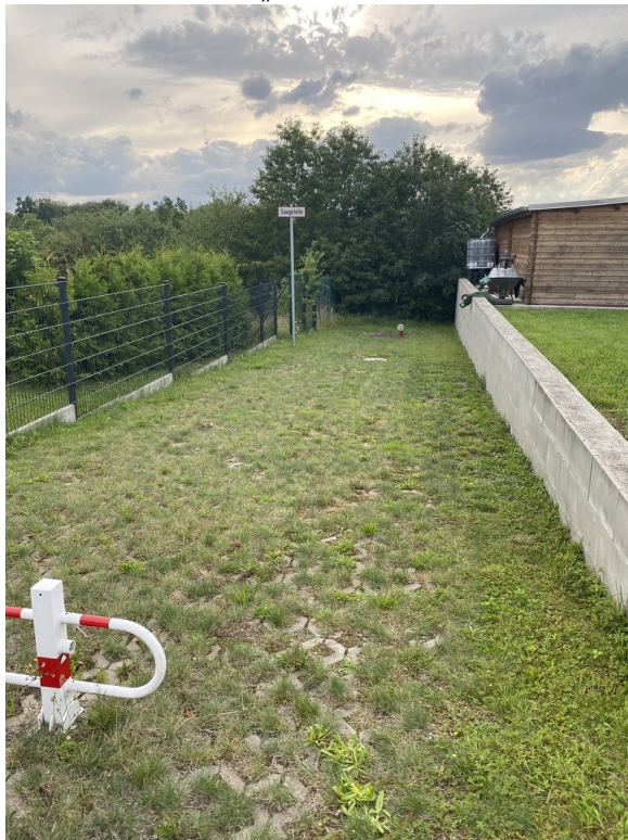
Abbildung 30: Zufahrt und Saugstelle am Löschteich "Brockenblick"
