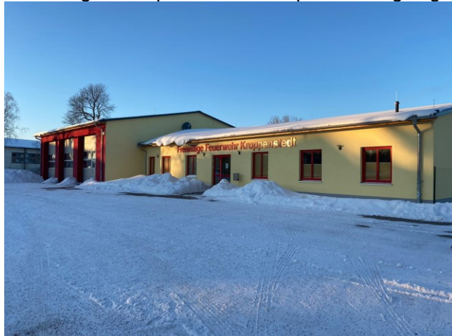
Abbildung 167: Feuerwehrhaus in Kroppenstedt
