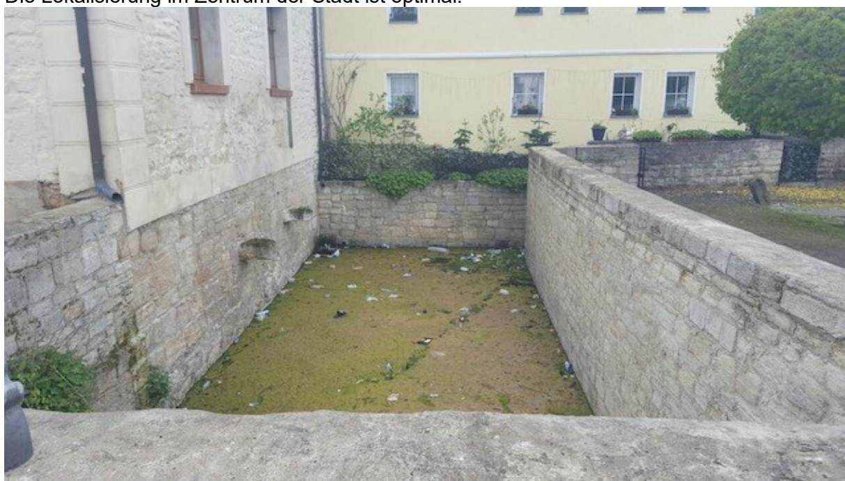
Abbildung 40: Die Tränke in Kroppenstedt kann als unerschöpfliche Löschwasserentnahmestelle genutzt werden
