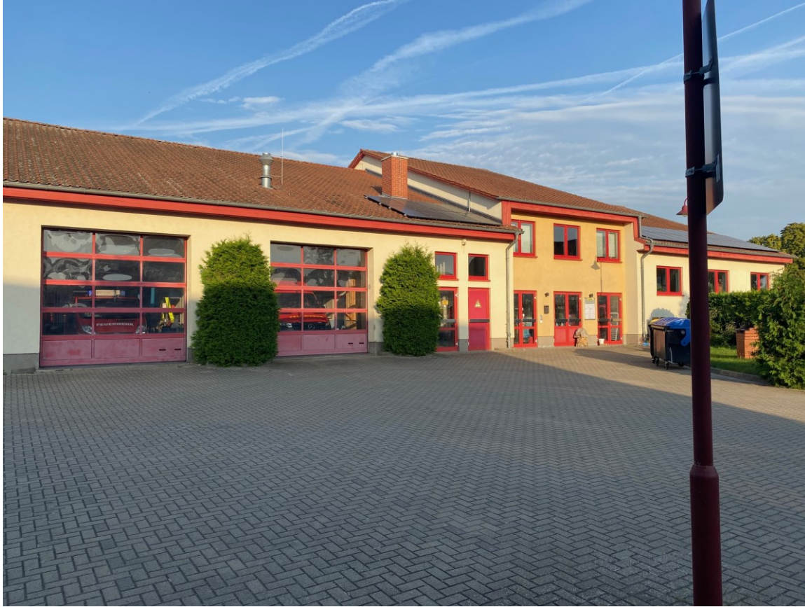
Abbildung 124: Das Feuerwehrhaus der FF Ausleben mit dem davorliegenden Parkplatz
