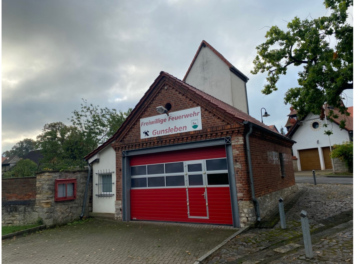
Abbildung 106: Feuerwehrhaus in Gunsleben
