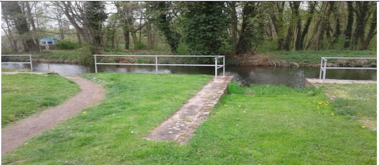
Abbildung 15: mögliche Löschwasserentnahmestelle am Mühlengraben aus Richtung Hinterstraße
