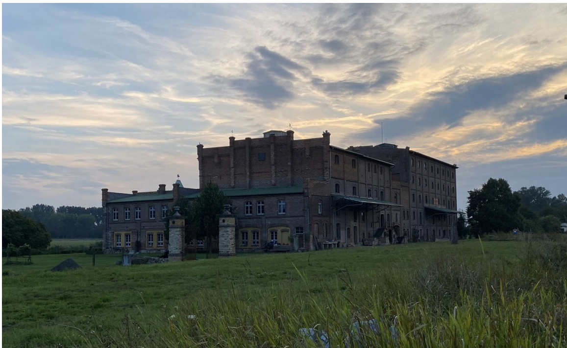
Abbildung 29: derzeit zum Beispiel nicht ausreichend mit Löschwasser abgesichert, der alte Speicher in Gunsleben
