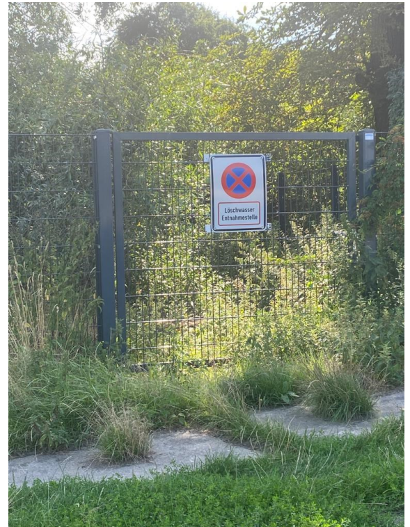
Abbildung 19: Zugang zum Löschwasserbrunne in der Straße Am Gehren Anger
