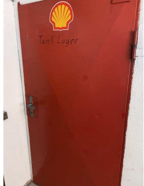
Abbildung 98: Das Tanklager entspricht nicht den Anforderungen für die Lagerung von Kraftstoffen in Garagen
