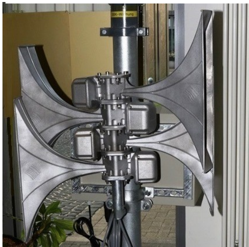
Abbildung 71: elektronische Sirene in der typischen Bauform, Quelle: Bundesamt für Bevölkerungsschutz und Katastrophenhilfe
