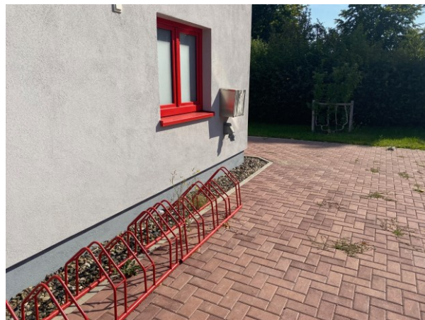
Abbildung 139: Neben den Fahrradständern befindet sich die Möglichkeit zum Anschluss der externen Spannungsversorgung
