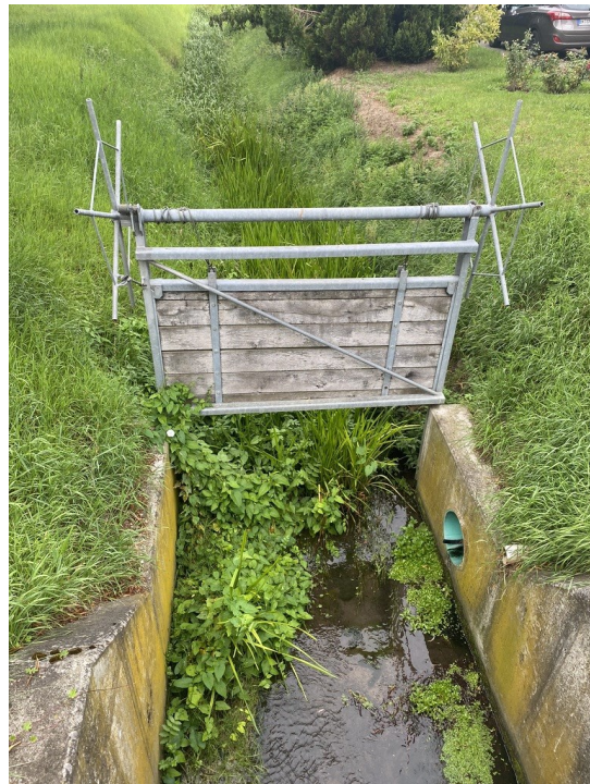
Abbildung 27: Wasserstand von nur zwei Zentimetern und geringer Fließgeschwindigkeit am gleichen Stauwehr im August 2023
