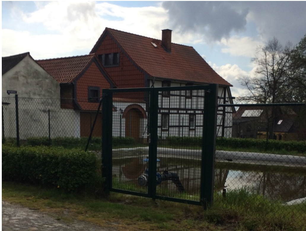
Abbildung 8: Löschwasserteich mit Saugstelle in Ausleben
