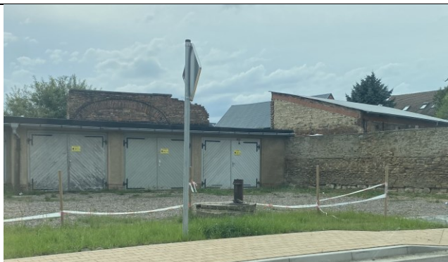
Abbildung 51: Brunnen in der Hamerslebener Straße, der für die Eignung zum Löschwasserbrunnen überprüft wurde
