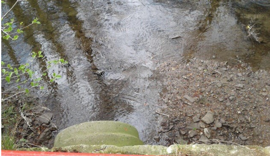
Abbildung 13: mögliche Entnahmestelle am Mühlengraben in Gröningen, aus Richtung Einnemerstraße
