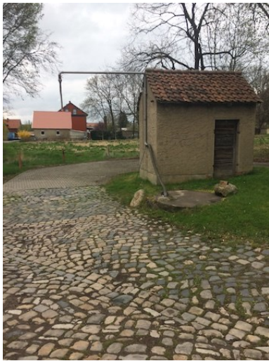
Abbildung 21: Löschwasserbrunnen in Gunsleben, mit dem Schuppen für die Pumpenbedienung
