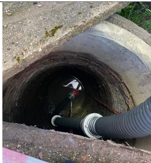
Abbildung 52: Der Brunnen war nach ca. 2 Minuten mit 600 Liter/min Wasserentnahme "leer" gezogen, es läuft nur sehr wenig Wasser nach.
