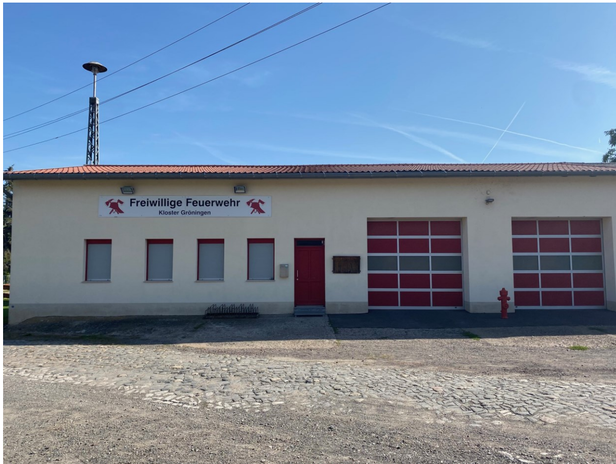
Abbildung 151: Das Feuerwehrhaus in Kloster Gröningen am Halberstädter Platz
