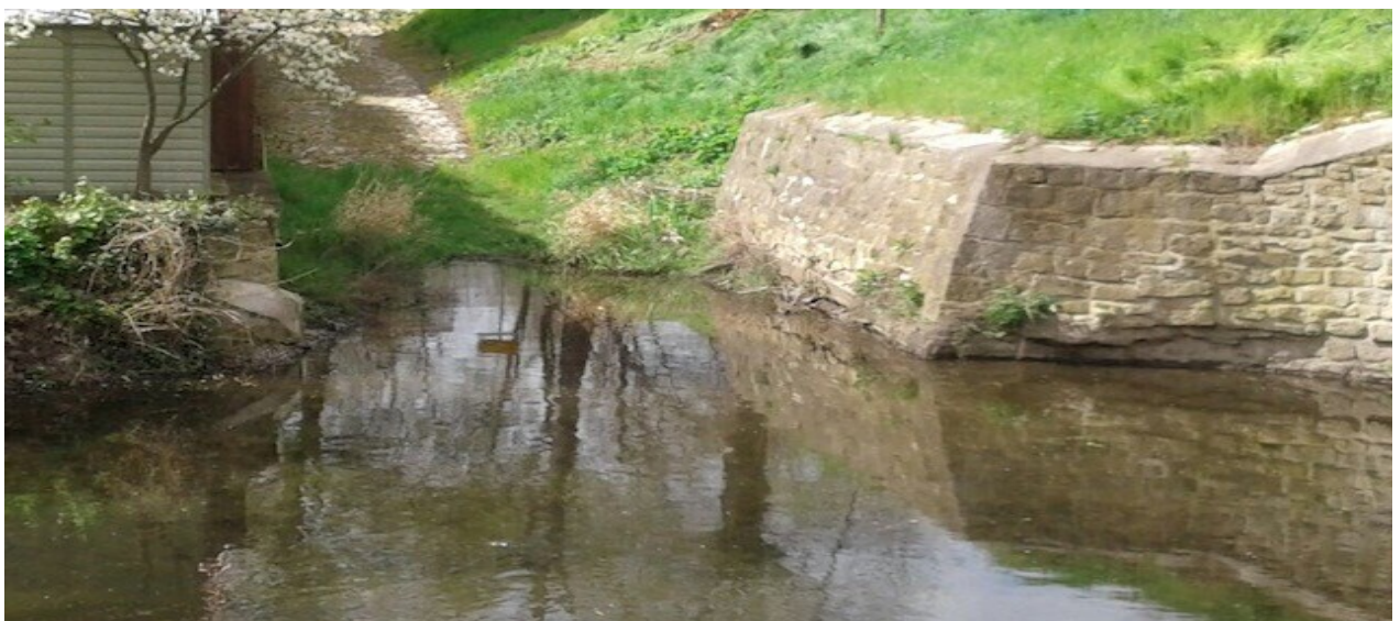
Abbildung 14: mögliche Löschwasserentnahmestelle am Kulturhaus
