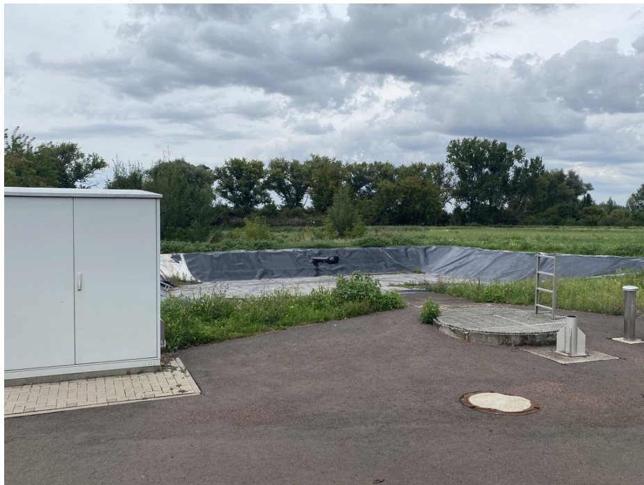
Abbildung 66: Regenwasserrückhaltebecken am Sportplatz
