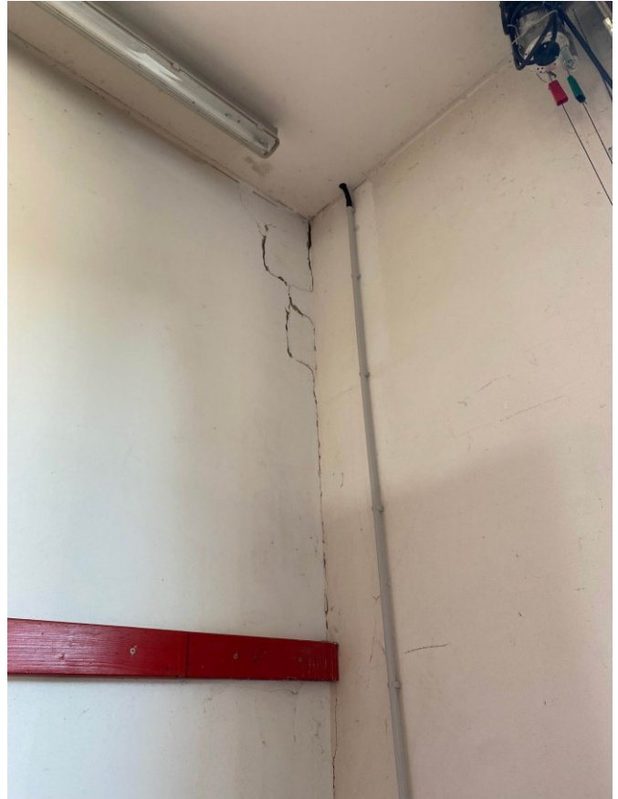
Abbildung 134: Setzungsrisse
