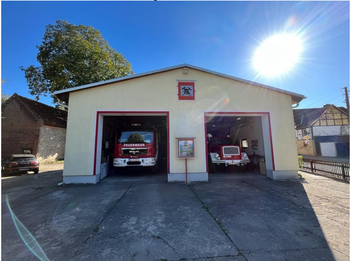
Abbildung 112: Feuerwehrhaus in Wulferstedt
