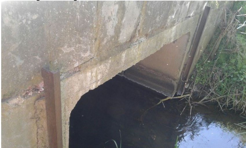
Abbildung 38: mögliche Staustelle an der ehemaligen Tränke
