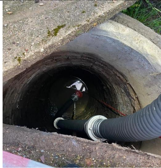
Abbildung 52: Der Brunnen war nach ca. 2 Minuten mit 600 Liter/min Wasserentnahme "leer" gezogen, es läuft nur sehr wenig Wasser nach.
