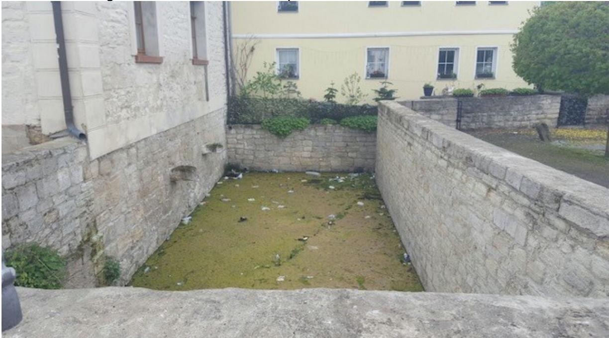
**Abbildung 40: Die Tränke in Kroppenstedt kann als unerschöpfliche Löschwasserentnahmestelle genutzt werden**
