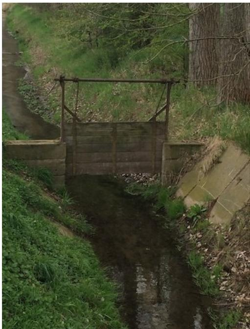
**Abbildung 24: Stauwehr als Löschwasserentnahmestelle am Ortsausgang Richtung Wackersleben, im Juni 2017**
