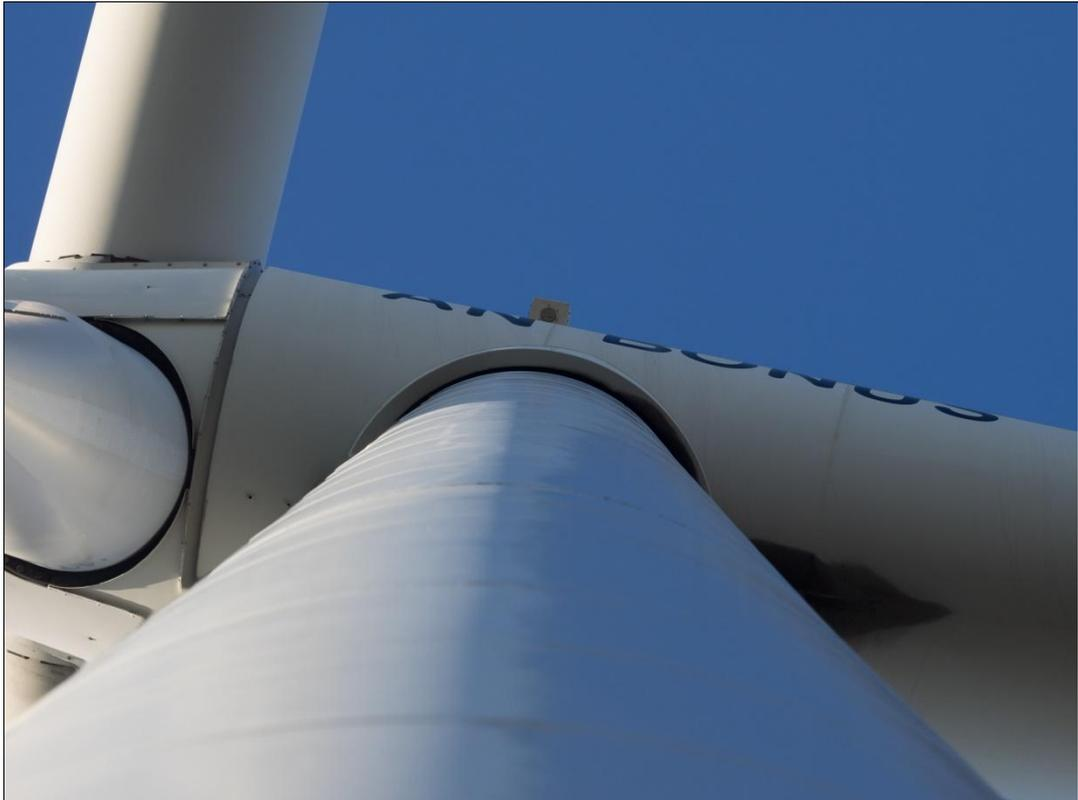
**Abbildung 2: Anlage am Bullenberg mit Lage der Mikrofondurchführung an der Seite der Gondel. Aufgrund technischer Eigenschaften der Anlage konnte eine Durchführung an der Unterseite nicht realisiert werden.**
