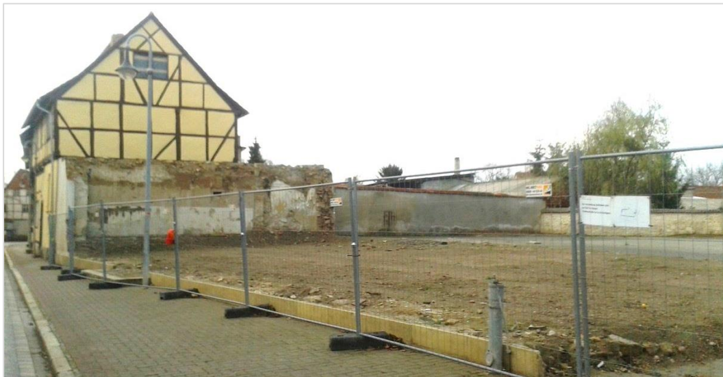
Baulücke des abgerissenen Rathauses im Dezember 2018
