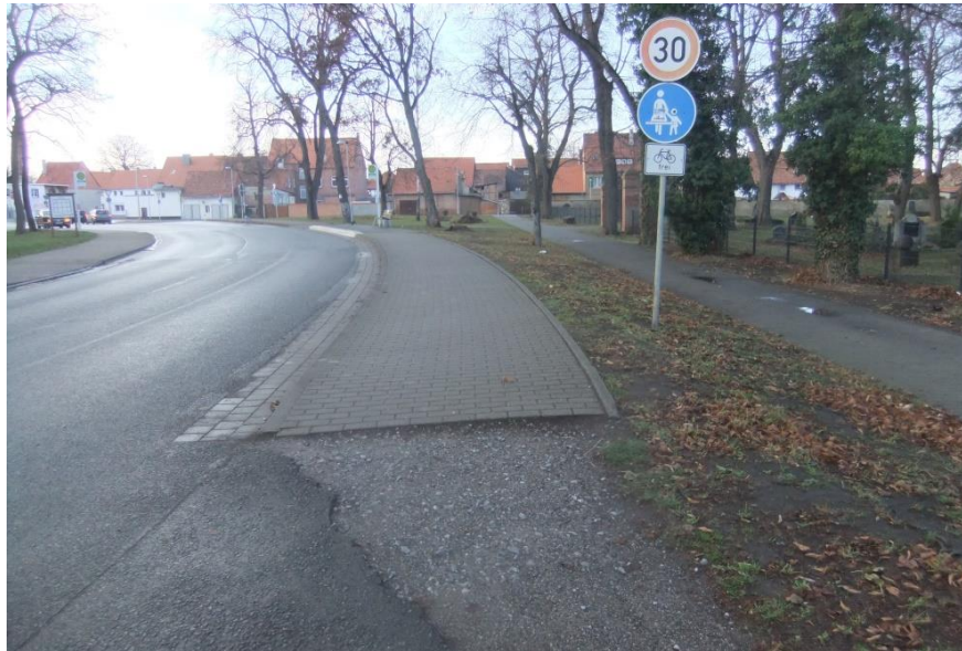
22. Magdeburger Straße, Nordseite, zwischen östlichem Friedhofsende und Discounter
