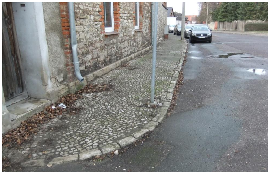
26. Südgröninger Tor, Westseite, Hausnr. 5b bis Hinterstraße
