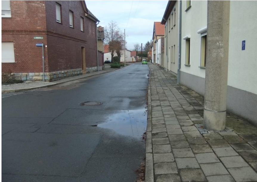
18. Heinrich-Julius-Straße, Ostseite, Hausnr.- 2-7
