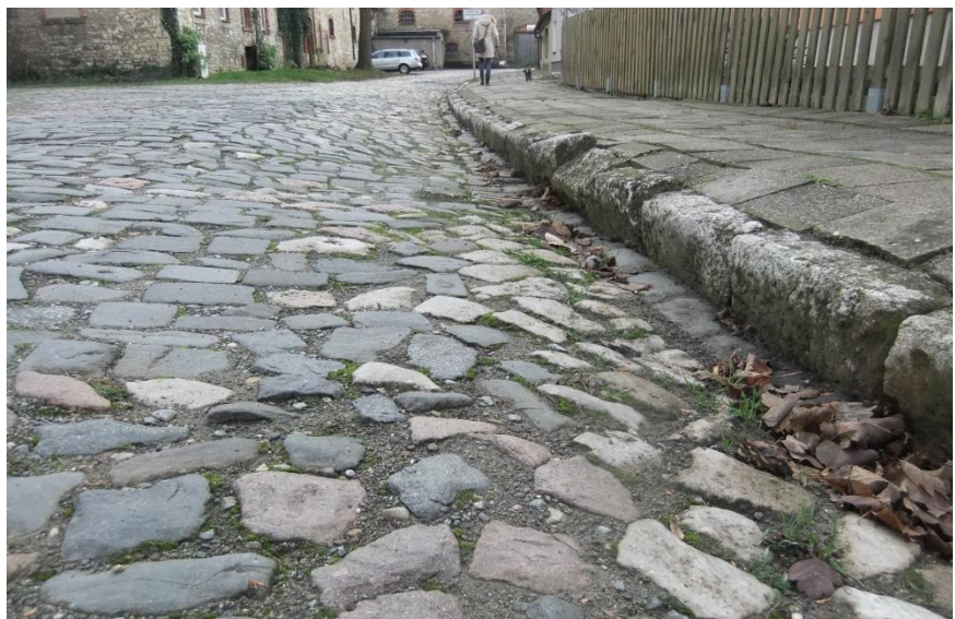
5. Burggraben, Westseite, Sackstraße bis Hausnr.2
